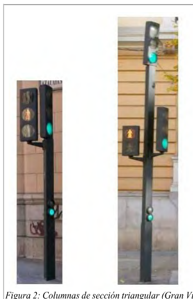
Figura 2: Columnas de sección triangular (Gran Vía)
