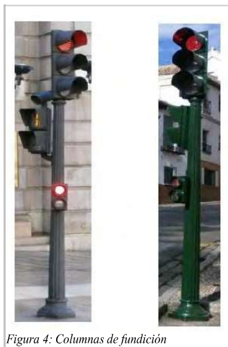
Figura 4: Columnas de fundición
