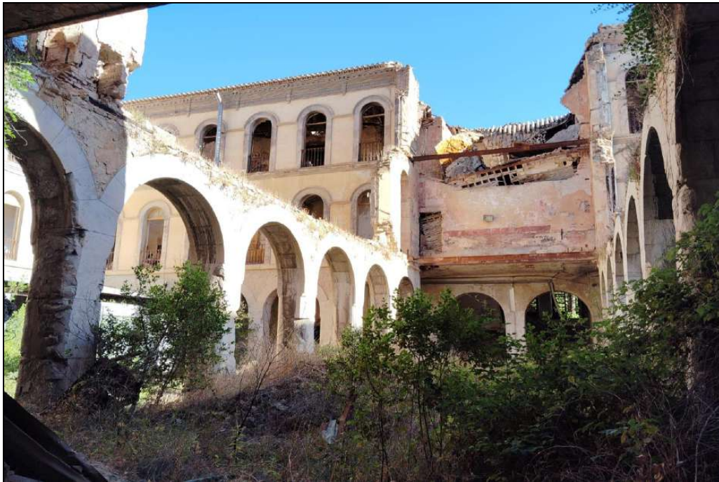
Estado en ruinas de la Zona interna del Claustro del Colegio Nuevo
