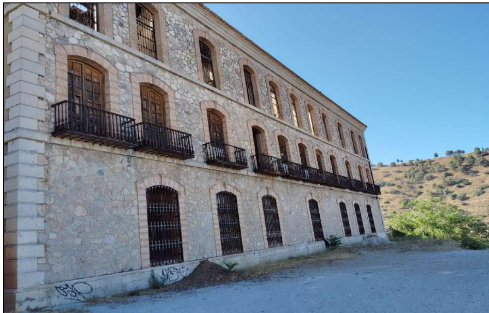
Fachada oeste del Colegio Nuevo
