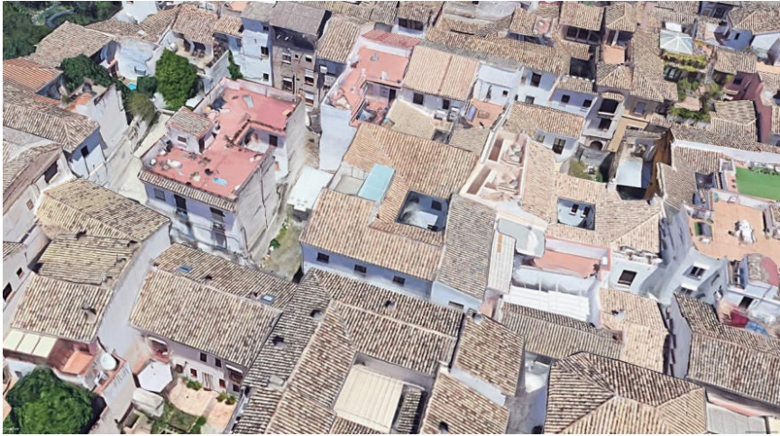
VISTAS AÉREAS DEL SOLAR
